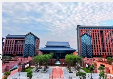
古籍馆(建设中)
